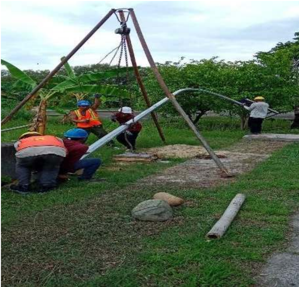
Gambar 33. Pemasangan Solar Cell
